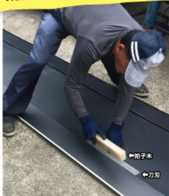
トタン板などを折り曲げる時に使う拍子木(写真↑)と刀刃(写真↑)です。
