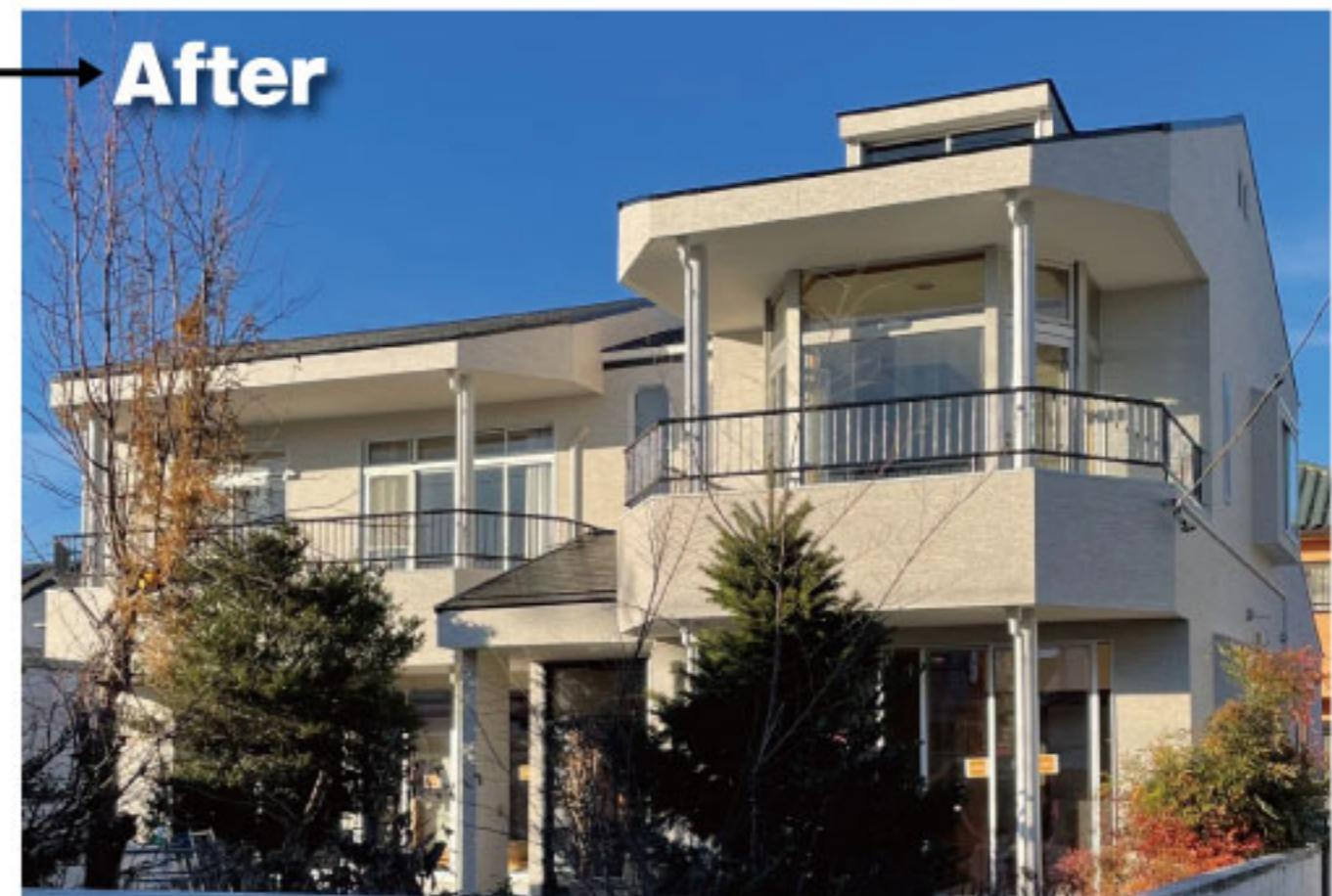
**POINT①** 外壁は窯業系サイディングという材料を使用。表面が剥れてしまい塗装では復旧が不可能なので新しいサイディングに交換しました。
