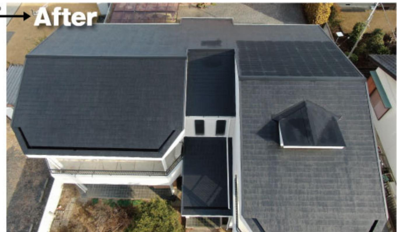
**POINT似** 屋根材はコロニアルという材料を使用していました。カバー工法をする方法がベストでしたが、今回は、塗装工事で仕上げました。1階の屋根は下地まで傷んでいたので、下地と屋根材も交換しました。
